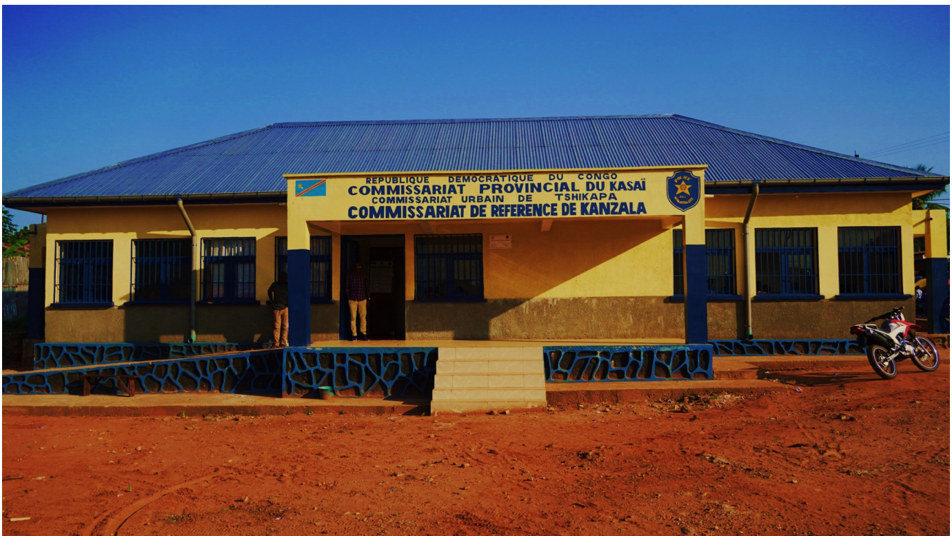
NOUVEAU COMMISSARIAT DE REFERENCE DE KANZALA. CONSTRUIT PAR L'OIM A TSHIKAPA, PROVINCE DU KASAI, ©IOM 2023
