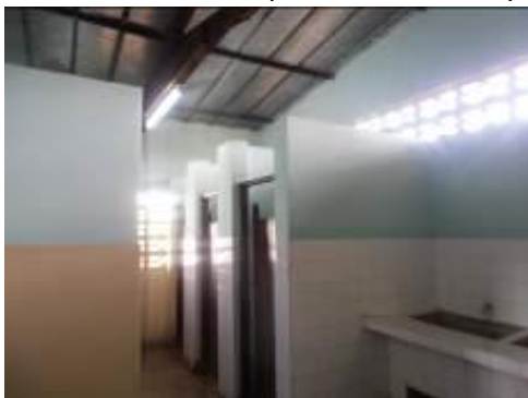
Toilettes et douches repeintes
